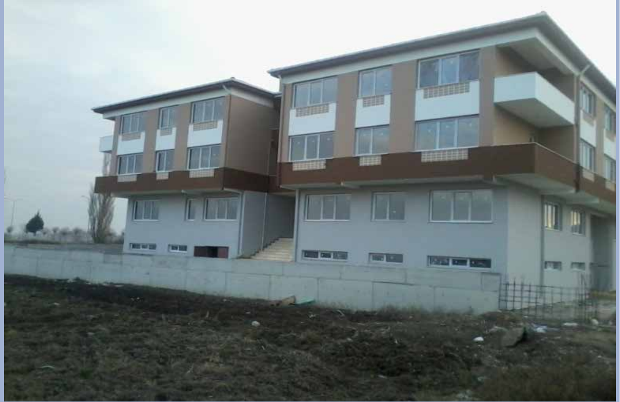
Enez İlçe Emniyet Müd. Lojmanlı Hizmet Binası (Sözl. Bedeli: 1.871.480,00) (%80 Seviye.)
