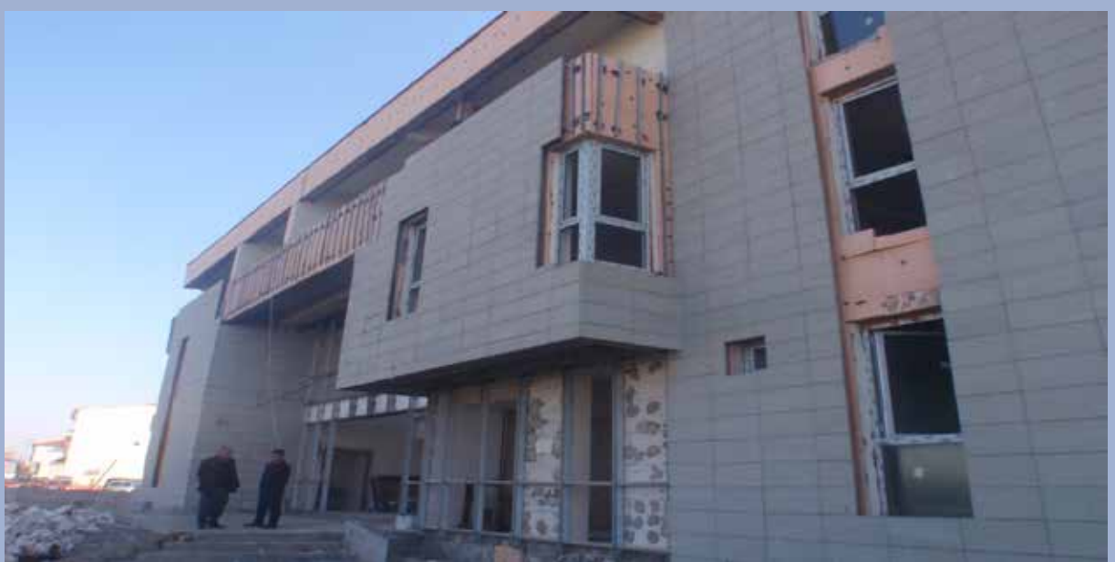
Meriç Toplum Saęlığı Merkezi Tadilatı (Sözleşme Bedeli: 977.040,00) (% 5 Seviyesinde)
