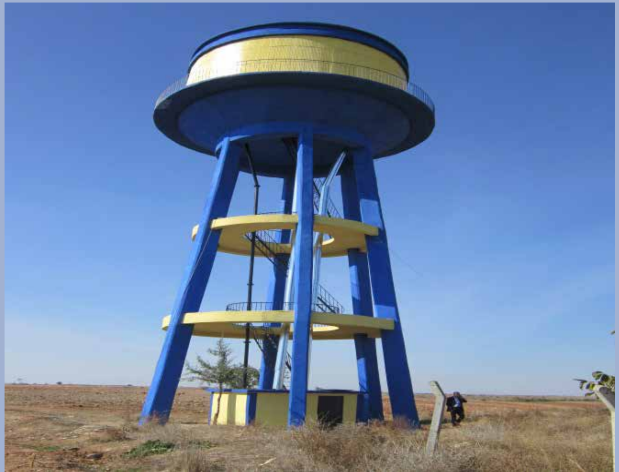
HAVSA İLÇESİ YOLAGELDİ KÖYÜ AYAKLI SU DEPOSU VE TERFİ BİNASI ONARIMI (KÖYDES)
