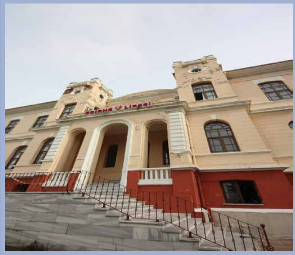
Önce cephesi boyatılan tarihi Edirne Lisesi binası
