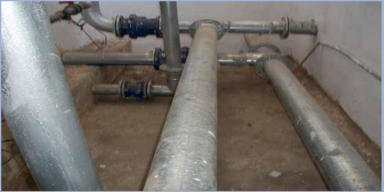
ADASARHANLI KÖYÜ İÇME SUYU SONDAJ KUYUSU
