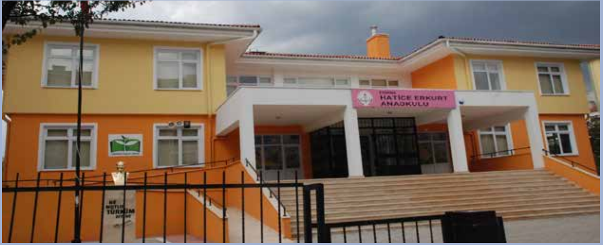
Merkez Göl Mahalle Anaokulu (Sözleşme Bedeli: 834.260,00) (Tamamlandı)
